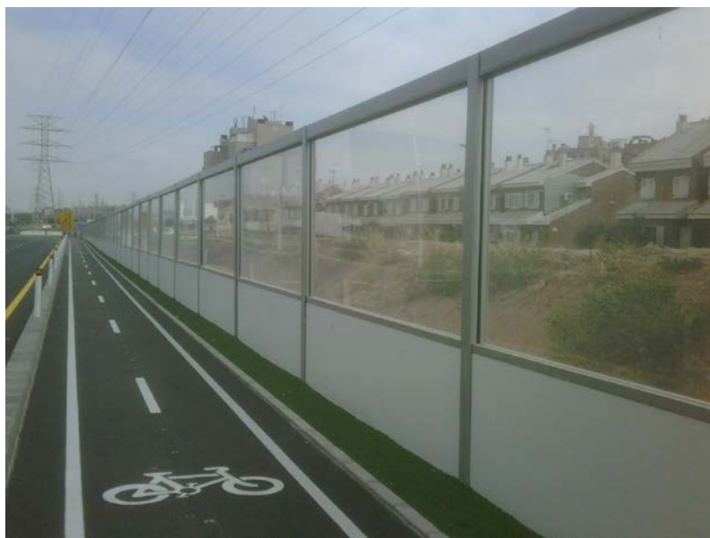
Láminas vitroflex® NOISE BARRIER colocadas en forma de barrera acústica para proteger una zona residencial del ruido del tráfico viario.
