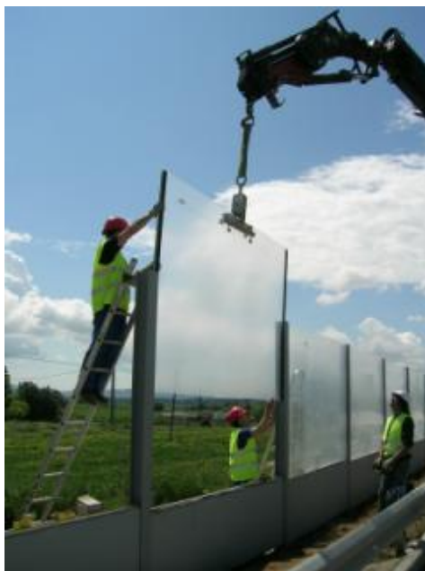
Instalación de una lámina vitroflex® NOISE BARRIER
