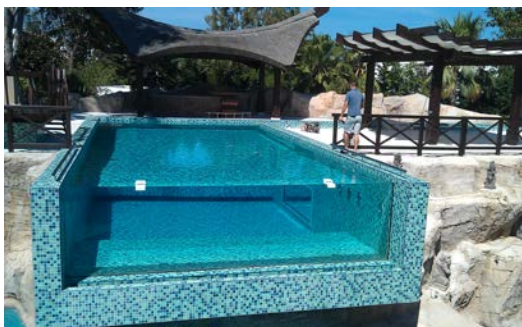
Piscina realizada con bloque AQUARIUM de 70 mm
